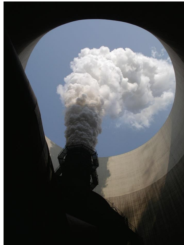
Hűtőtorony, közepén a kéntelenítő kéményével
