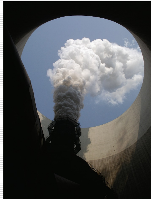
Hűtőtorony, közepén a kéntelenítő kéményével
