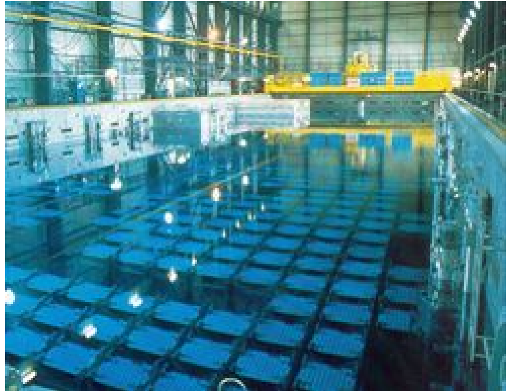
Kiégett üzemanyag átmeneti tárolómedencéje egy franciaországi reprocesszáló üzemben.
