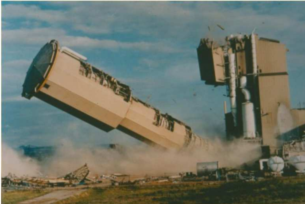
28. ábra Az ICI fermentor bontása
