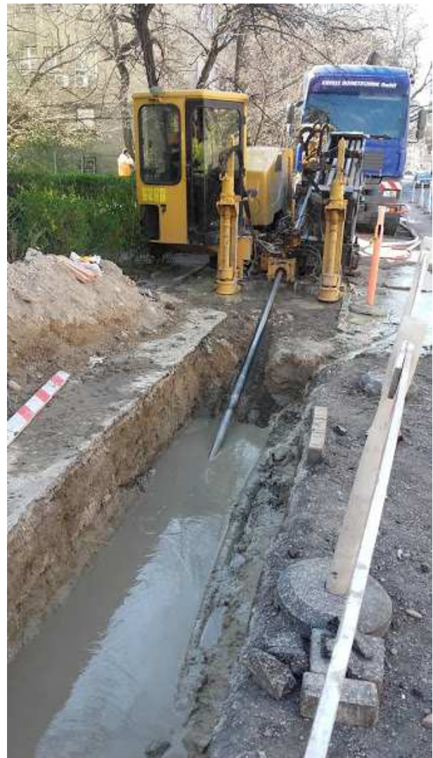
159. ábra Fűrőberendezés és öblítő folyadék (ferde fúrás a Karinthy Frigyes út alatt, saját felvétel)
